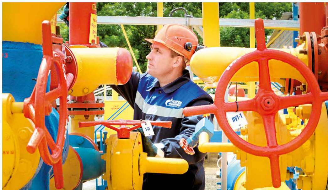
Проверка работоспособности предохранительного клапана
