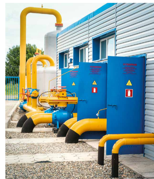
Узлы мехочистки и редуцирования
