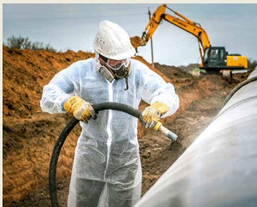
Подготовка трубы к изоляции
