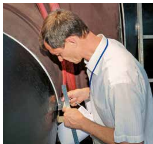
Замер точности стыковки тройника
