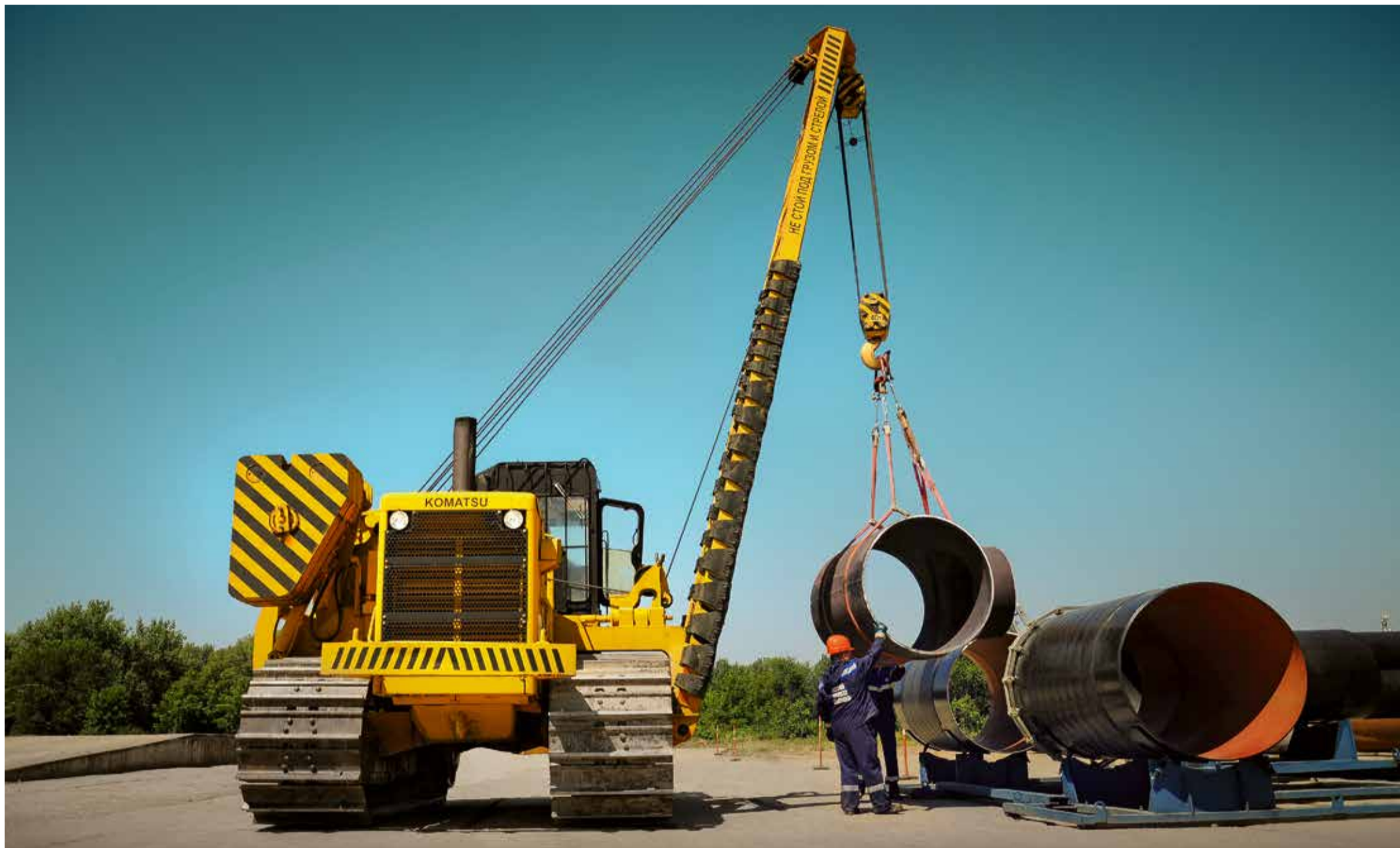
Установка конкурсантами тройника на место условной врезки
