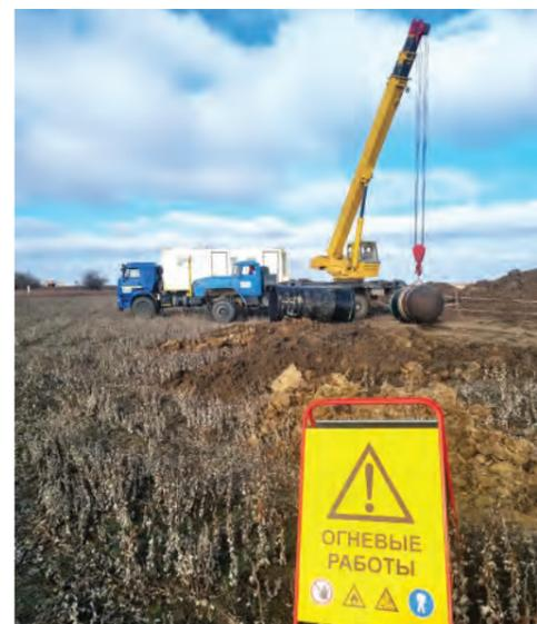
устранения влаги из котлованов планируем использовать мотопомпы и погружные насосы. По предварительным данным, в общей сложности нам предстоит заменить около трехсот метров трубы.
