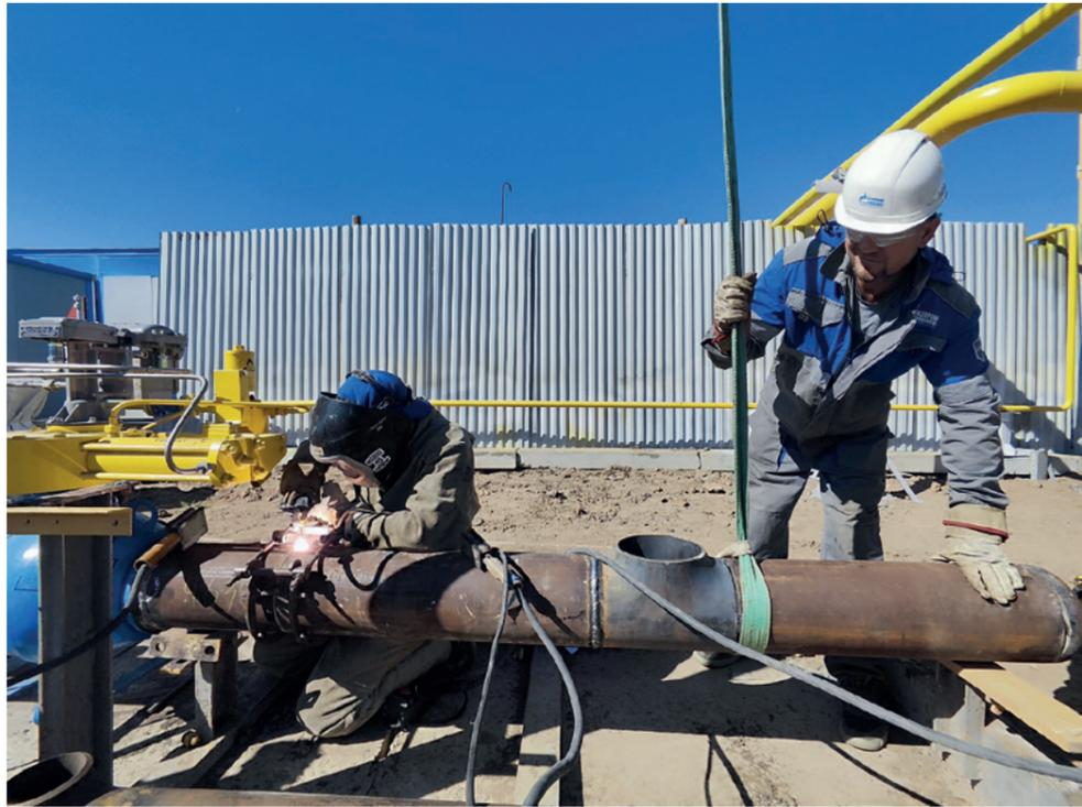
**Б**лок редуцирования и блок переключения — на станции бригады выполняют монтаж и сварку нового оборудования. Параллельно на производственном объекте благоустраивают территорию: засыпают пустоты щебнем, укладывают плитку, устанавливают бордюры. Электрогазосварщики, линейные трубопроводчики, монтажники, водители, разнорабочие — ГРС на новый уровень выводят более десятка человек. Для обеспечения рабочего процесса бригады используют автокран, экскава-
