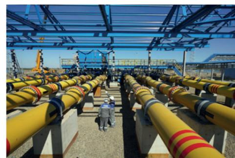
краска трубопроводов, проводится обустройство внутристанционных и подъездных дорог, идет подключение к действующему газопроводу. Строительство станции в значительной степени осложнила близость грунтовых вод. Нам пришлось проводить подготовительные работы и осушать траншеи с помощью специальных установок.
