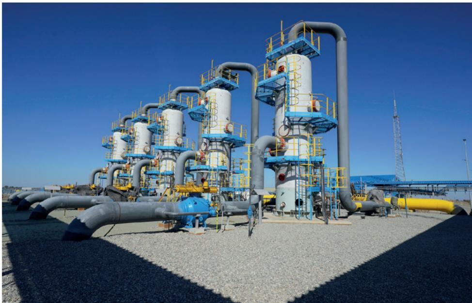
Газ очистить, редуцировать и измерить — три основные задачи новой газоизмерительной станции. Производственный объект после ввода в эксплуатацию станет принимать природное топливо, идущее из подземного хранилища, а также работать при закачке газа.
