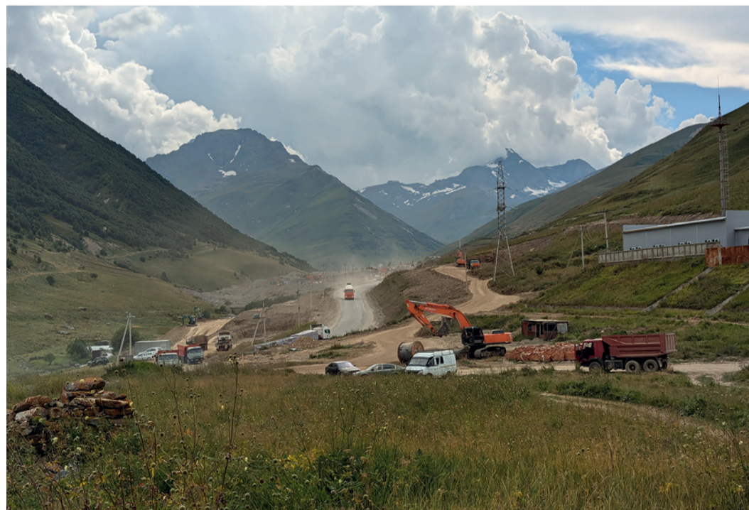
Строительство дороги к горнолыжному курорту «Мамисон»
