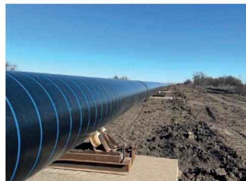
— Сварочные работы получились объемными, — рассказал ведущий инженер по эксплуатации нефтегазопроводов Астраханского филиала Владимир Каракастанда. — В общей сложности рабочие сварили более 160 стыков. Все соединения прошли дубль-контроль, выполненный дефектоскопистами Невинномысского управления. Состояние изоляции проверили инженеры электрохимзащиты Астраханского филиала. Строительный контроль на объекте провели специалисты Инженерно-технического центра.
