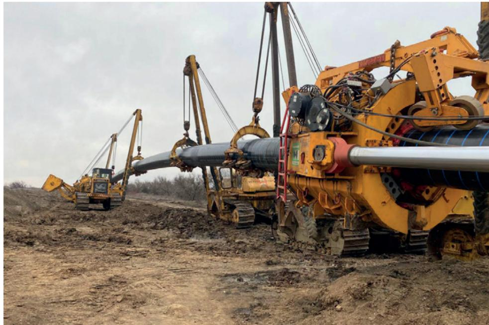
Две реки и две дороги — новый участок газовой магистрали преодолел рекордный путь. С помощью буровой установки трубную плетть длиной в два километра протянули под водными и дорожными преградами. Масштабные работы провели специалисты подрядной организации при участии газодовиков Астраханского, Невинномысского филиалов и Инженерно-технического центра.
