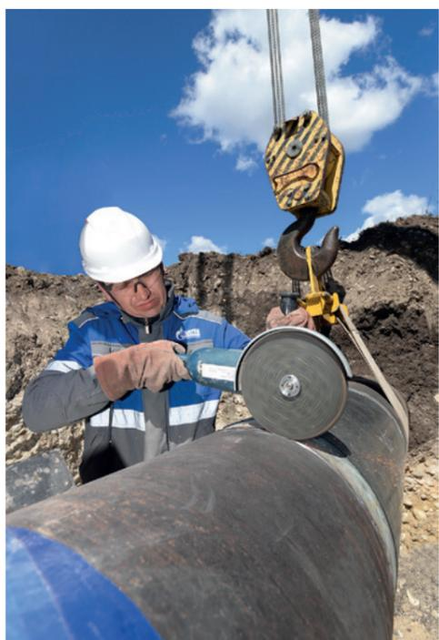
Обработка сварного шва
