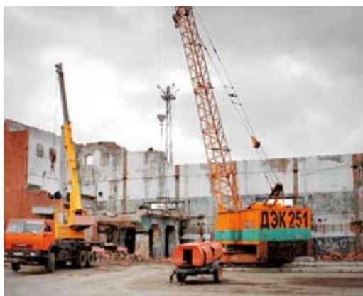
Место проведения работ
