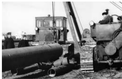
Строительство второй нитки Ставрополь – Москва
