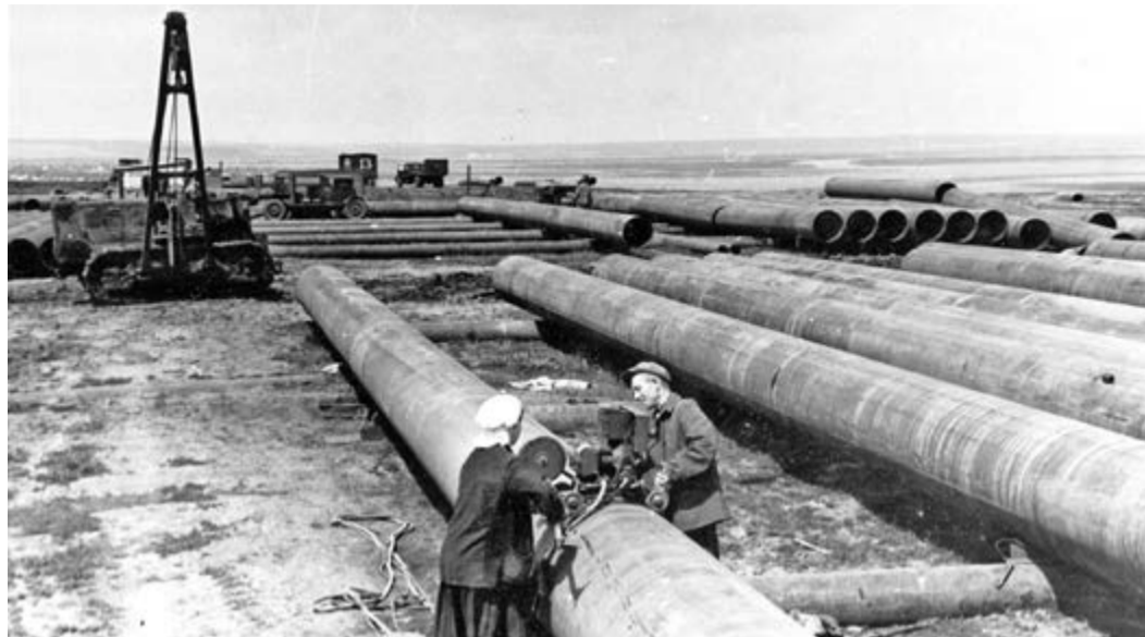
Строительство второй линии газопровода Ставрополь – Москва. Сварка стыка труб, 1958 г.
