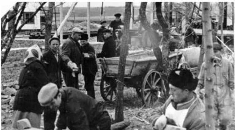
Строительство мастерской промысла № 3
