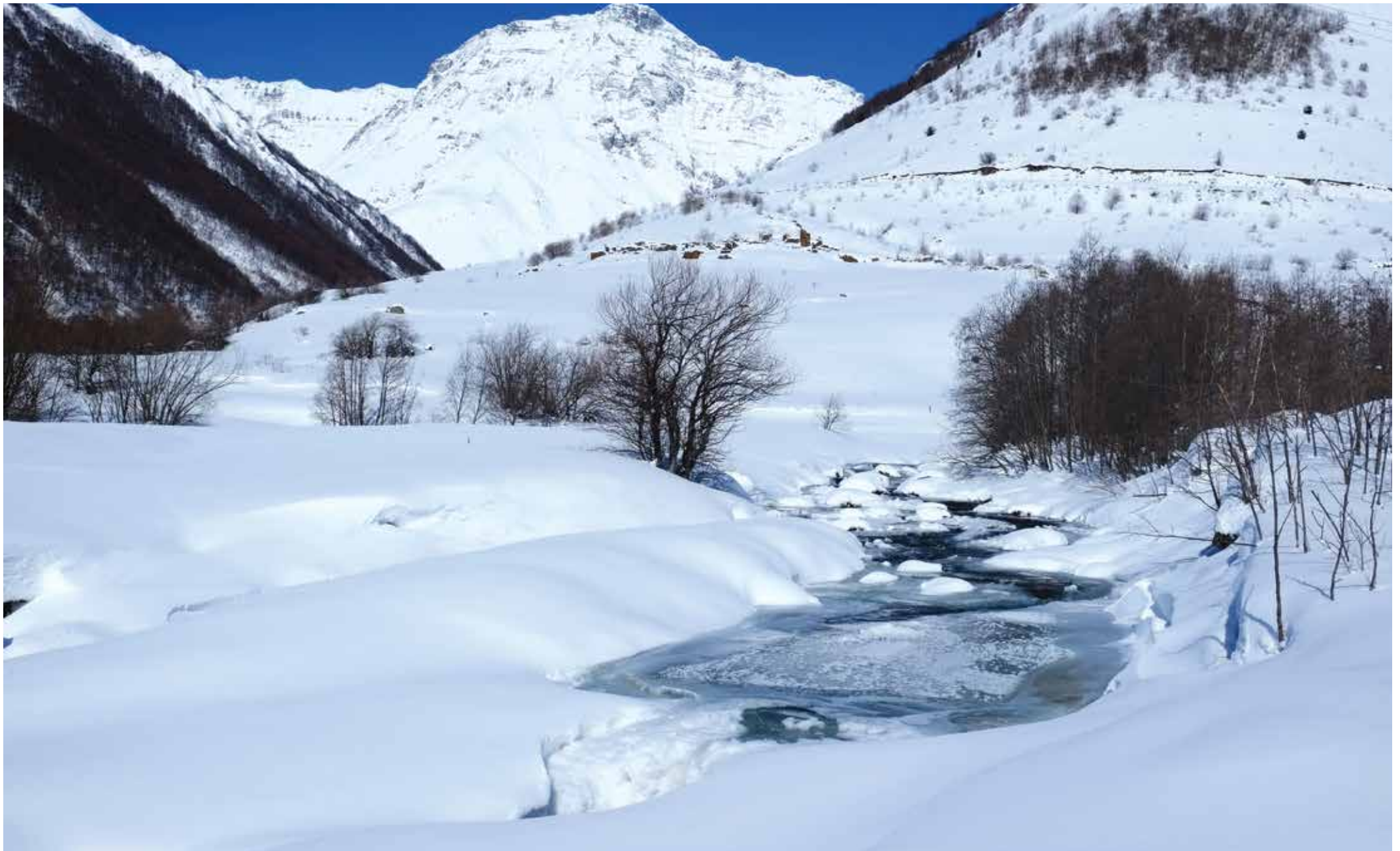
Сотый километр магистрального газопровода Дзуарикау — Цхинвал
