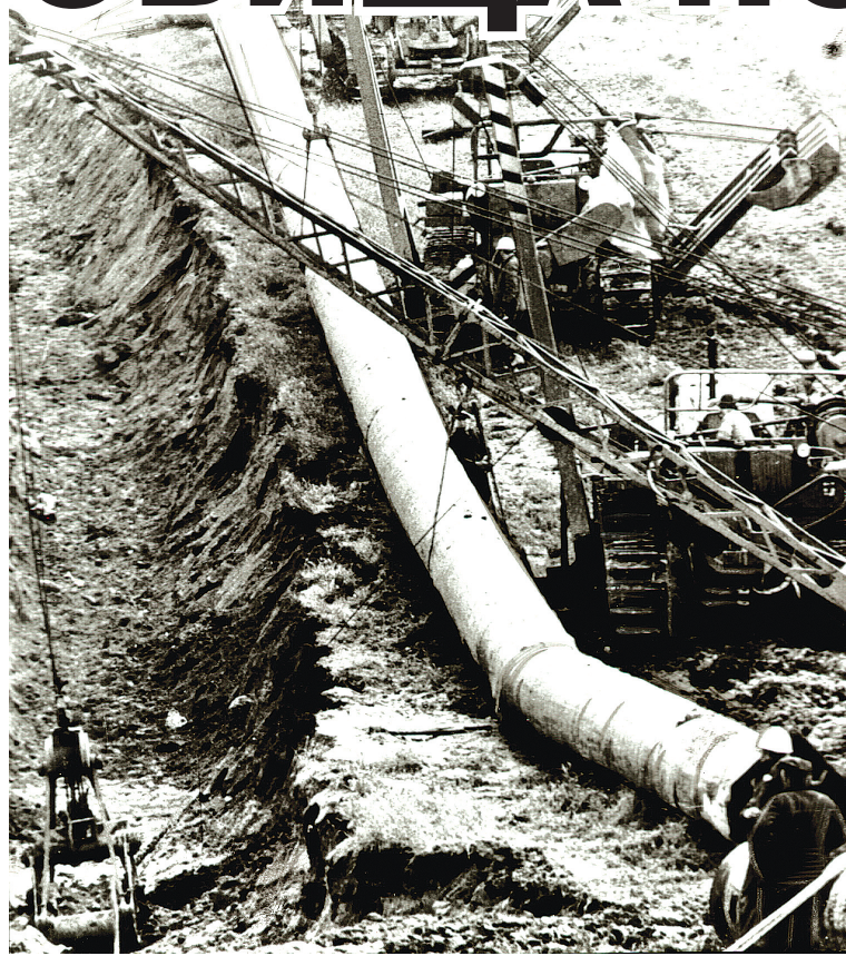
Строительство газопровода «Ставрополь-Москва», 1950-е гг.
