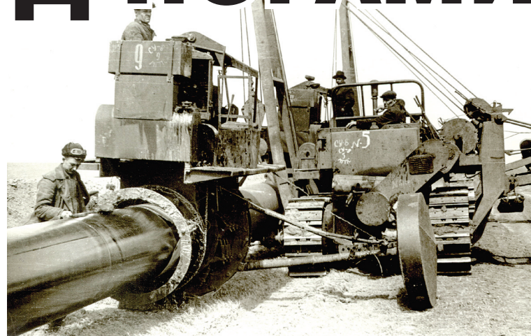
Укладка газопровода «Ставрополь-Москва», 1955-1956 гг.
