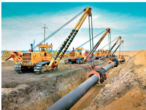
Укладка газопровода в траншею
