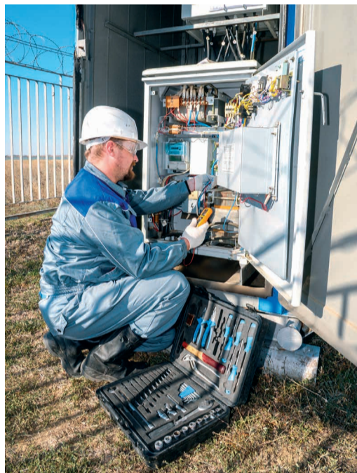
Техническое обслуживание станции катодной защиты
