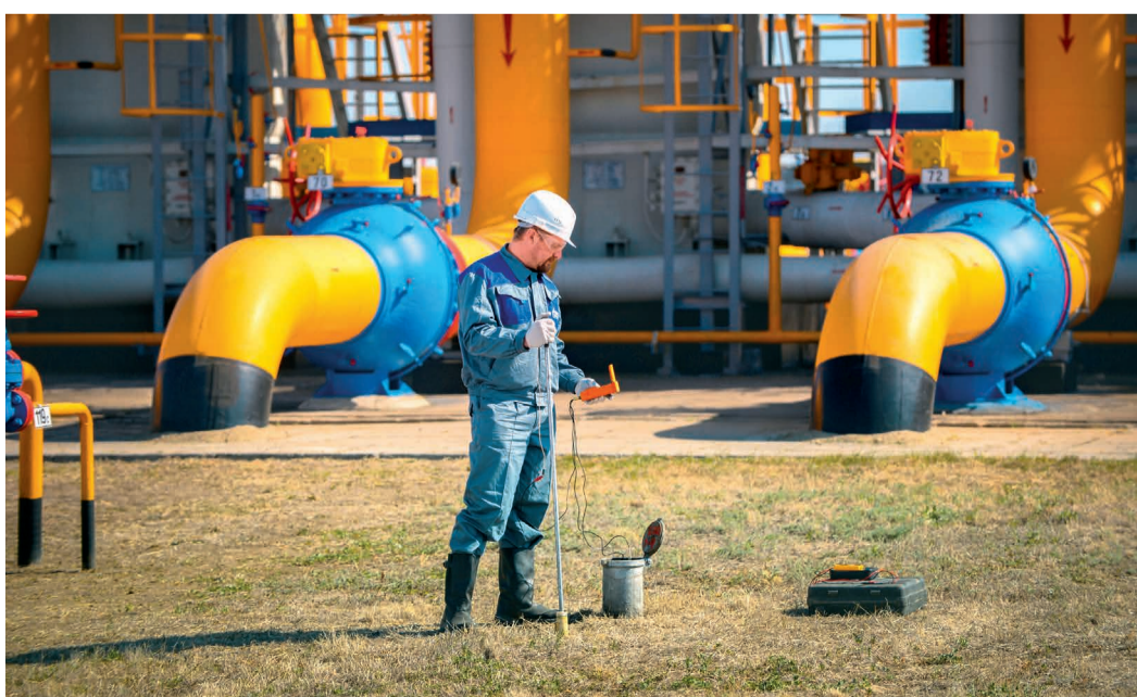
Замер защитного потенциала КС
