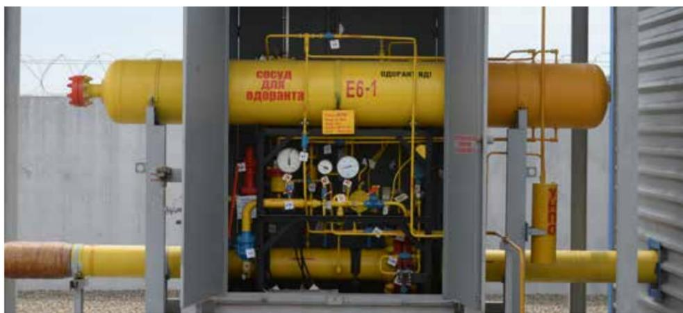
сные трубки, вывода из строя автоматику. Введенный в поток газа метанол частично поглощает водяные пары и переводит их в раствор, не образующий гидратов или образующий их при более низких температурах.
