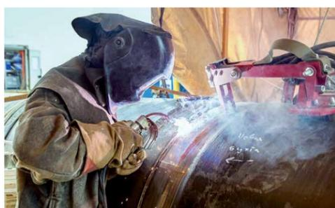
ловий сварочного процесса во многом определяет уровень эксплуатационной надежности газопроводов и производственного оборудования.
