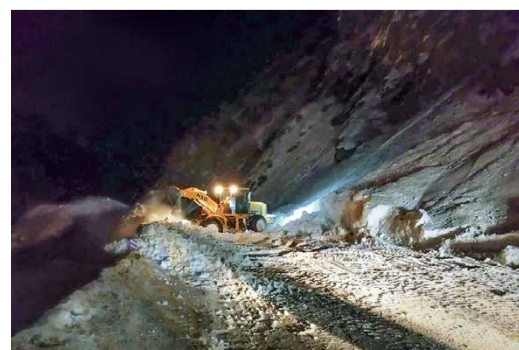
Работы по расчистке дорог ведутся ночью...
