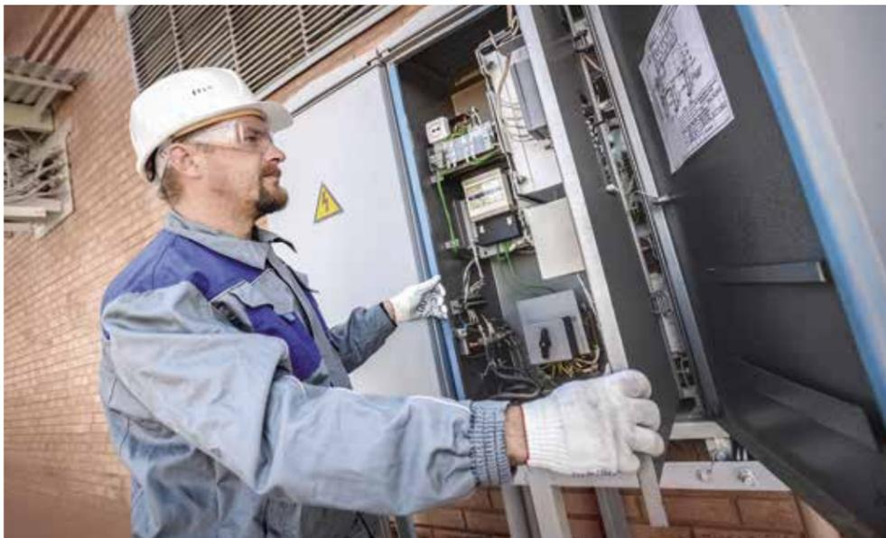
Техническое обслуживание установок катодной защиты
