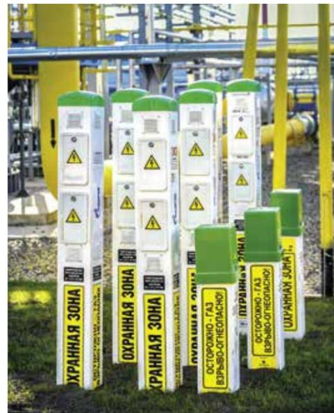
Система коррозионного мониторинга
