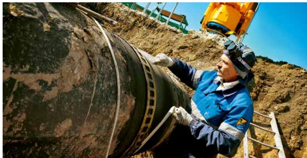
Подготовка к вырезке катушки
