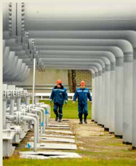
Осмотр оборудования АВО газа
