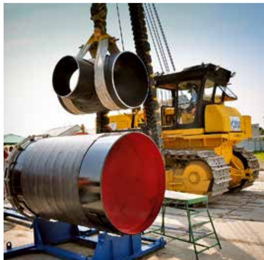
Конкурс машинистов трубоукладчика
