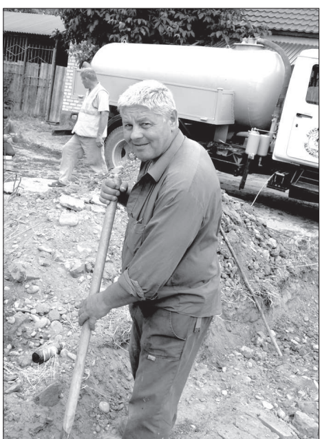
● Бригадир бригады аварийно-восстановительных работ Г. Анисимов.
