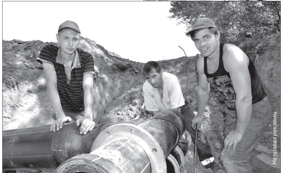
● Бригада слесарей аварийно-восстановительных работ - Е. Белоусов, С. Черкашин, В. Гончаров.
