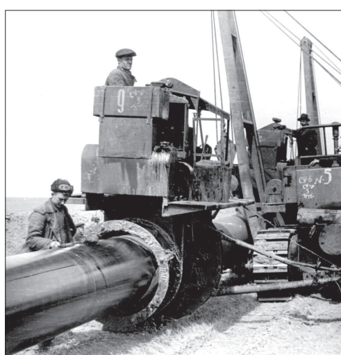
● Укладка трубопровода на трассе «Ставрополь - Москва». 1955 - 1956 гг.
