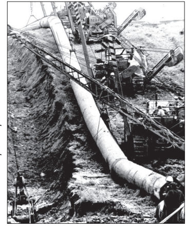
● Строительство газопровода «Ставрополь - Москва». 1950-е годы.
