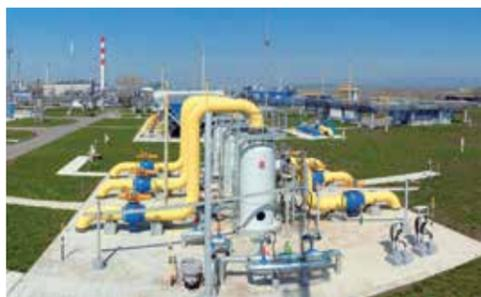
применяют циклонные пылеуловители, работающие по принципу использования центробежных сил для улавливания взвешенных частиц.
