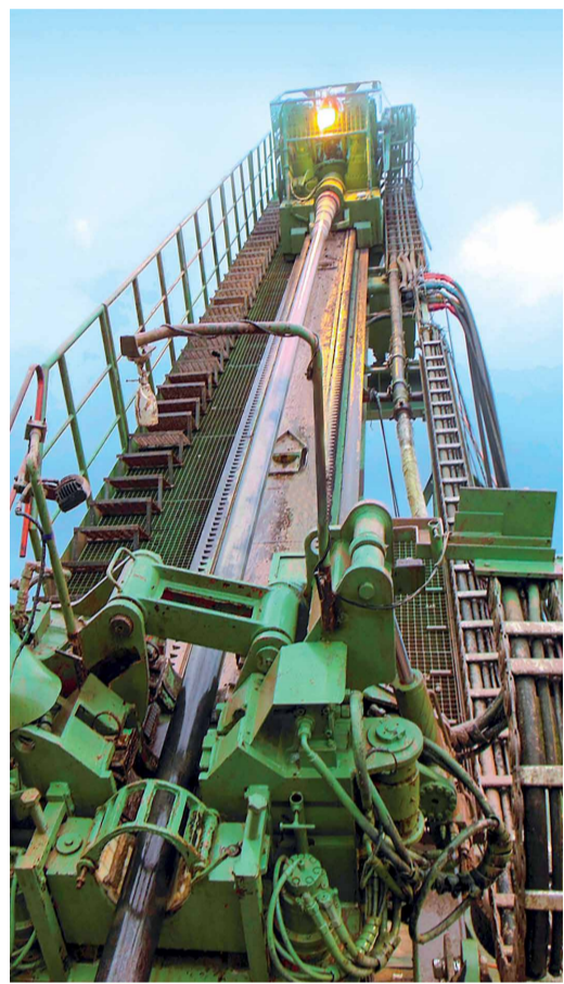
Установка наклонно-направленного бурения
