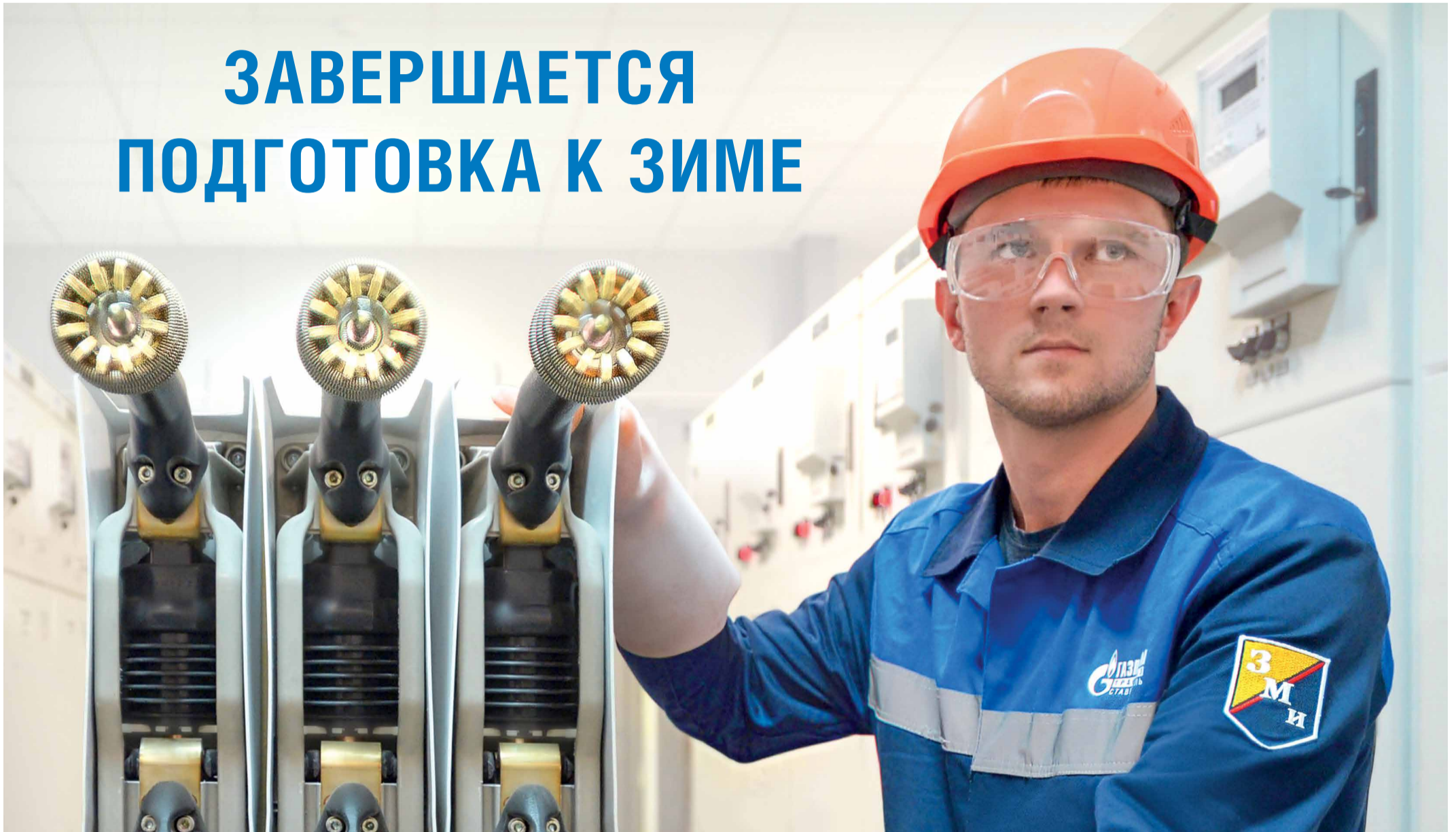
Техническое обслуживание оборудования закрытого распределительного устройства компрессорного цеха № 1 на КС «Невинномысск»
