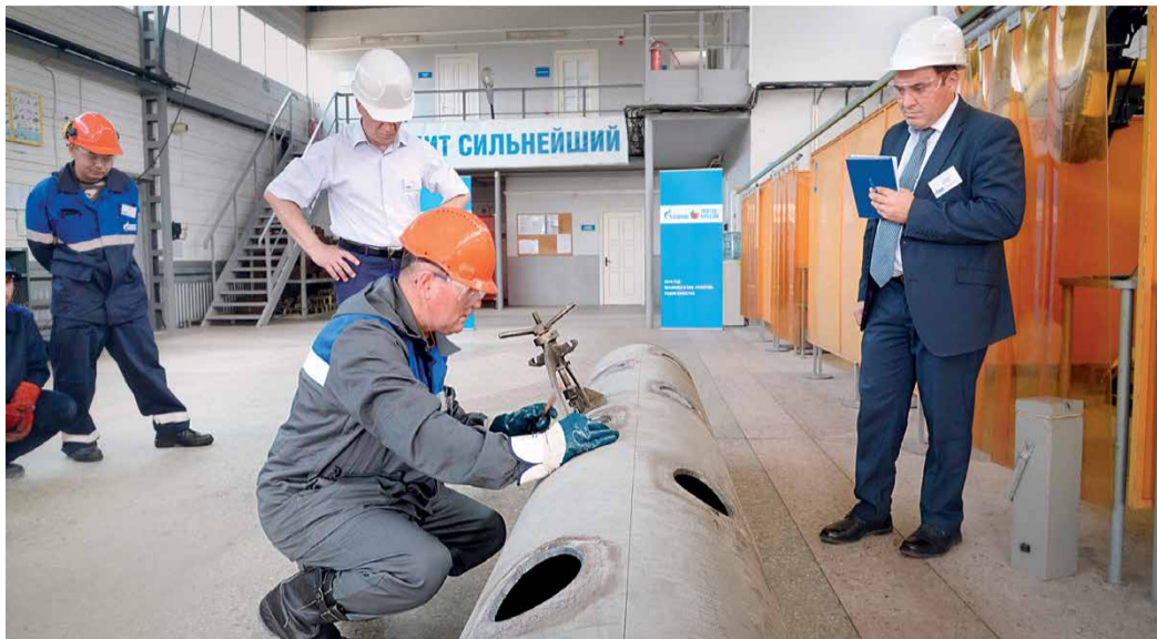
Практический этап — подготовка и монтаж технологической заплата
