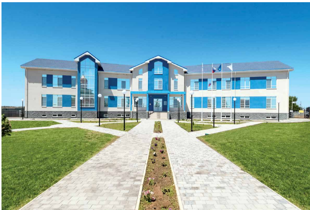
Новый административно-бытовой комплекс Зензелинского ЛПУМГ
