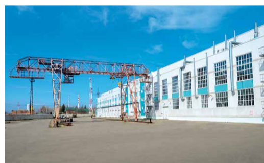
Новый корпус ЦМПИ
