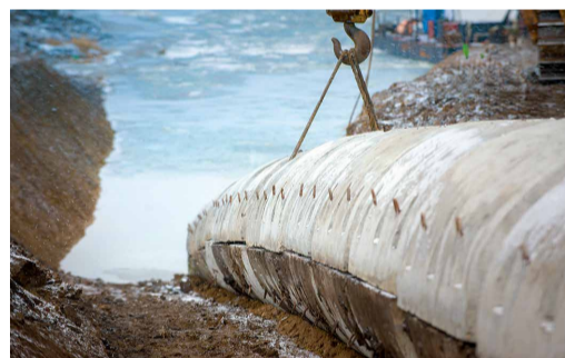
Ремонт подводного перехода магистрального газопровода
