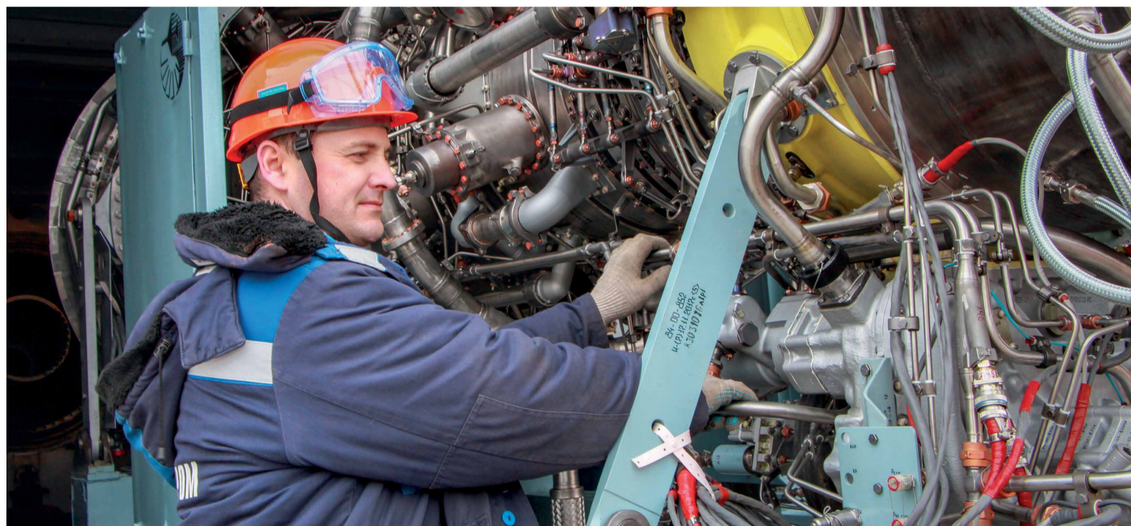
Монтаж технологической обвязки
