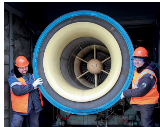
Установка лемникатного воздухозаборника
