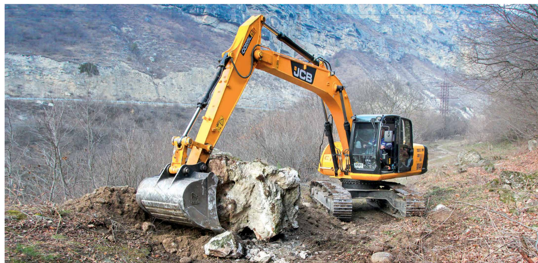
Очистка газовой трассы от скальных глыб
