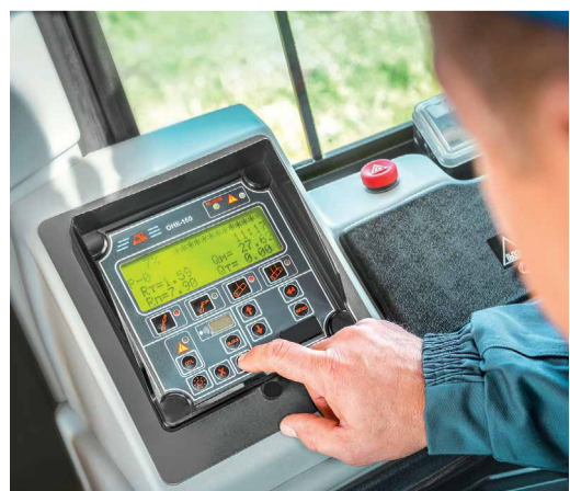
Приборы безопасности в кабине трубоукладчика
