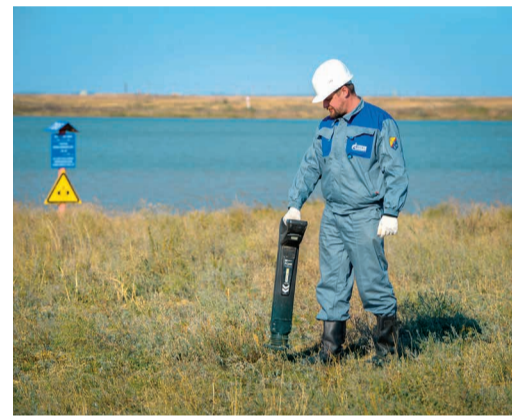
Определение заглубления газопровода
