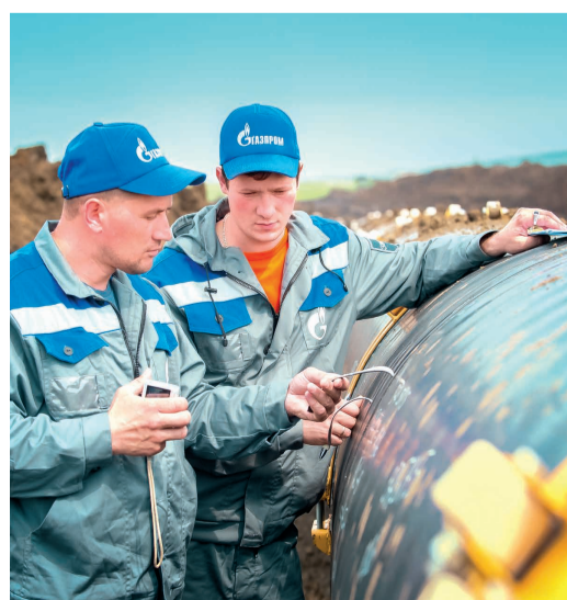
Проверка качества изоляции на МГ
