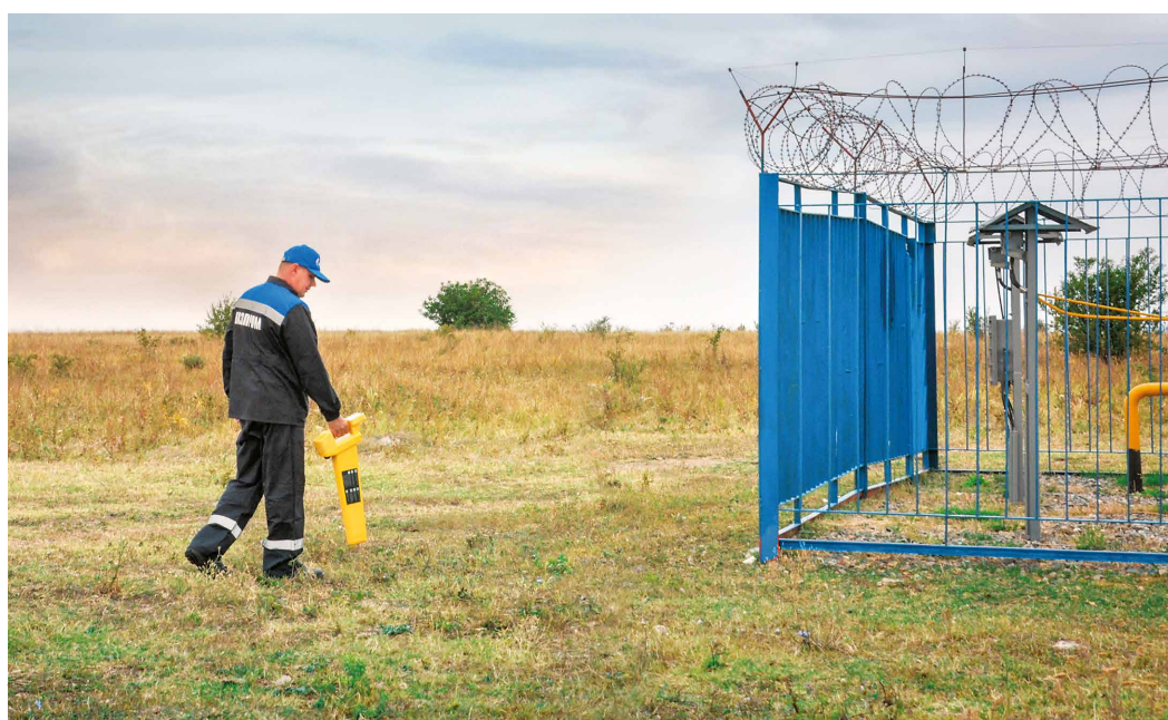
Определение трассы прохождения и глубины залегания кабеля с помощью кабелеискателя
