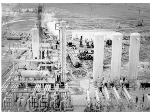
Монтаж цеха очистки и осушки газа, 1959 г.
