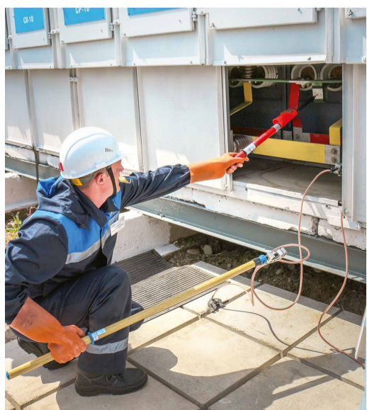
Установка переносного заземления
