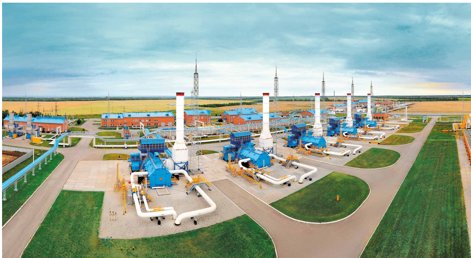
Компрессорная станция «Сальская»
