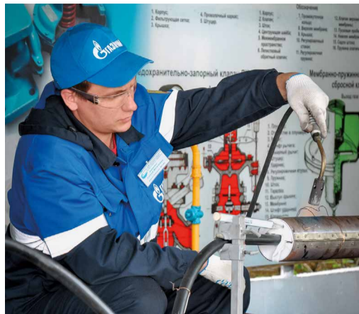
Монтаж муфты на медножильном кабеле
