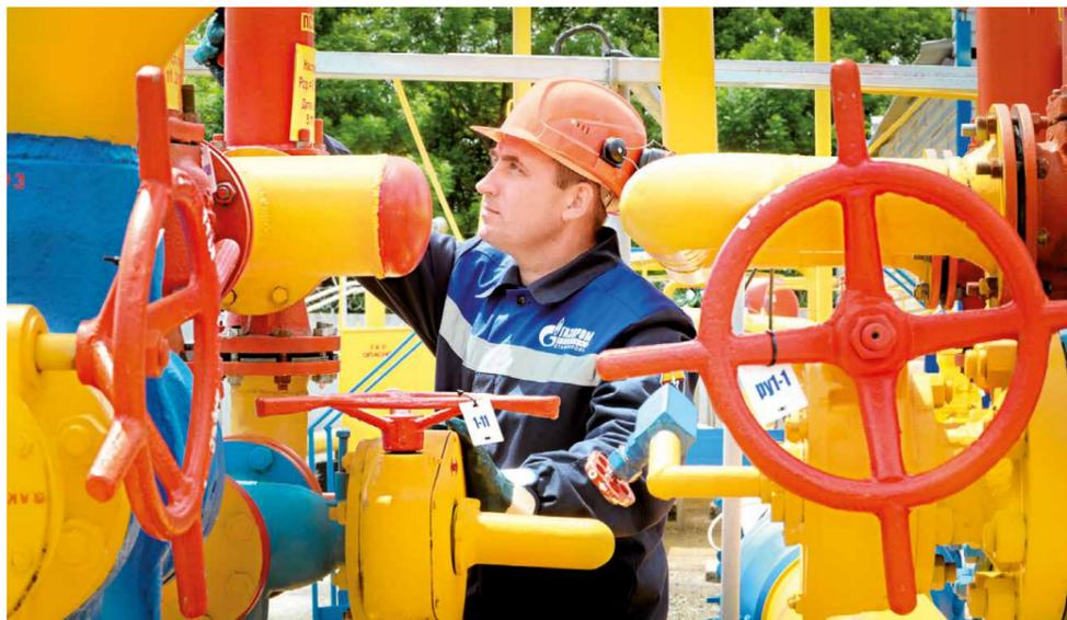
Проверка работоспособности предохранительного клапана
