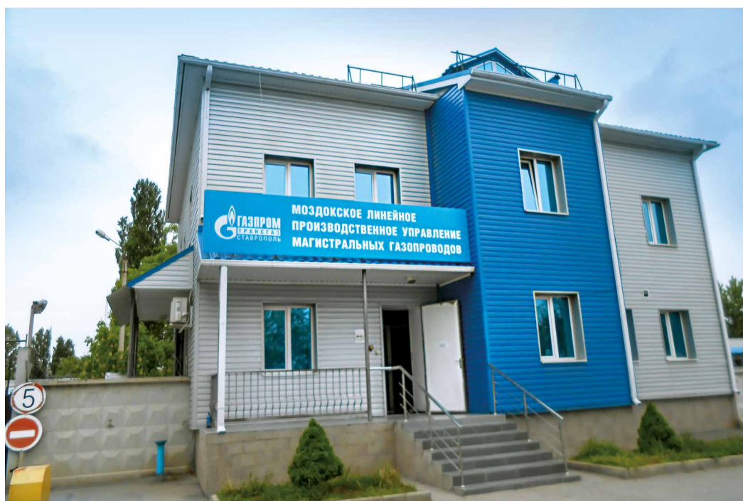
Здание Моздокского ЛПУМГ
