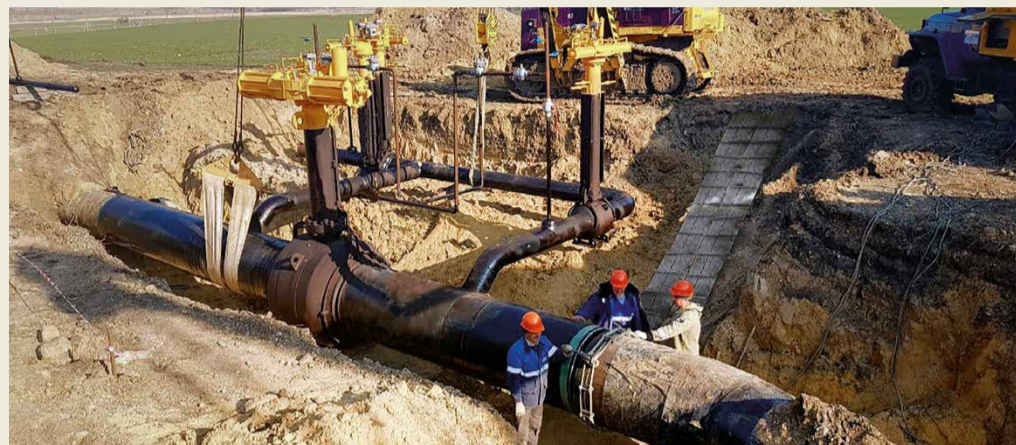
После огневых работ по отключению станции бригада ЛЭС выполнила замену кранового узла
