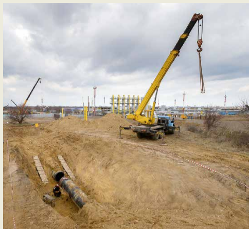
Подготовка к установке заглушки
