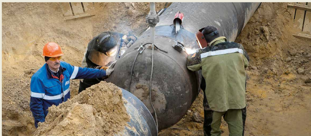
Монтаж силовой заглушки
