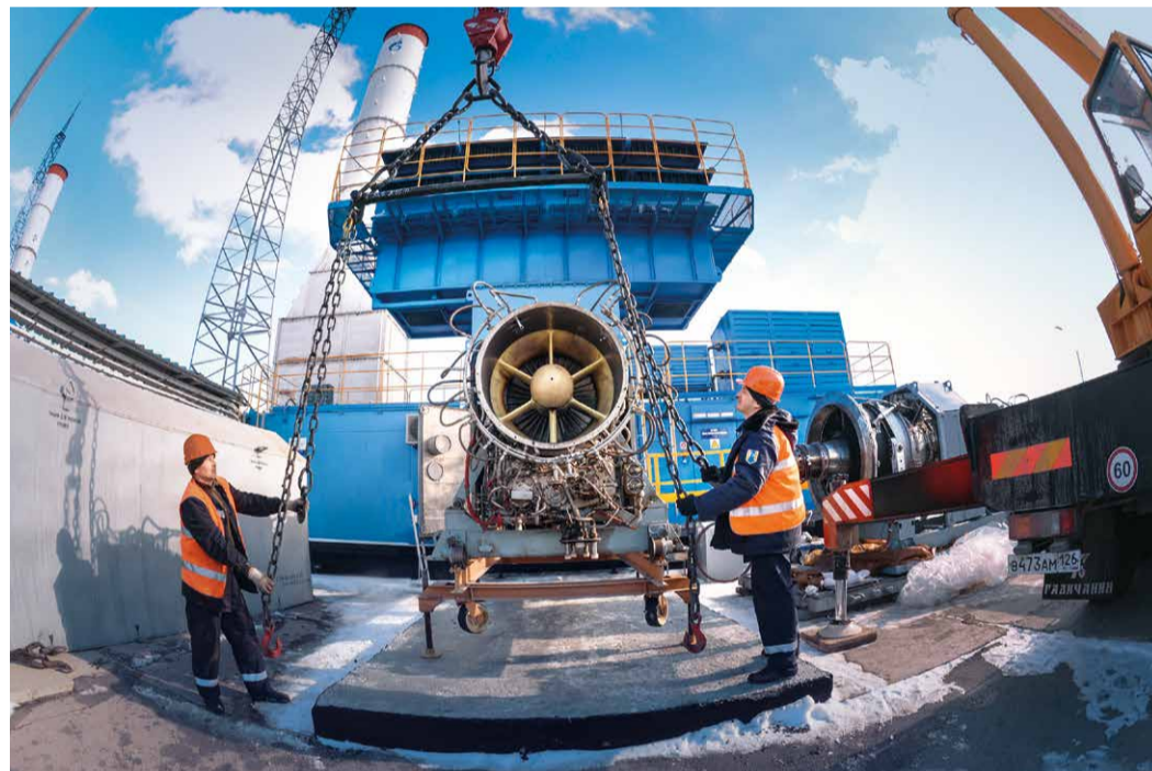
Стропальщики за работой
