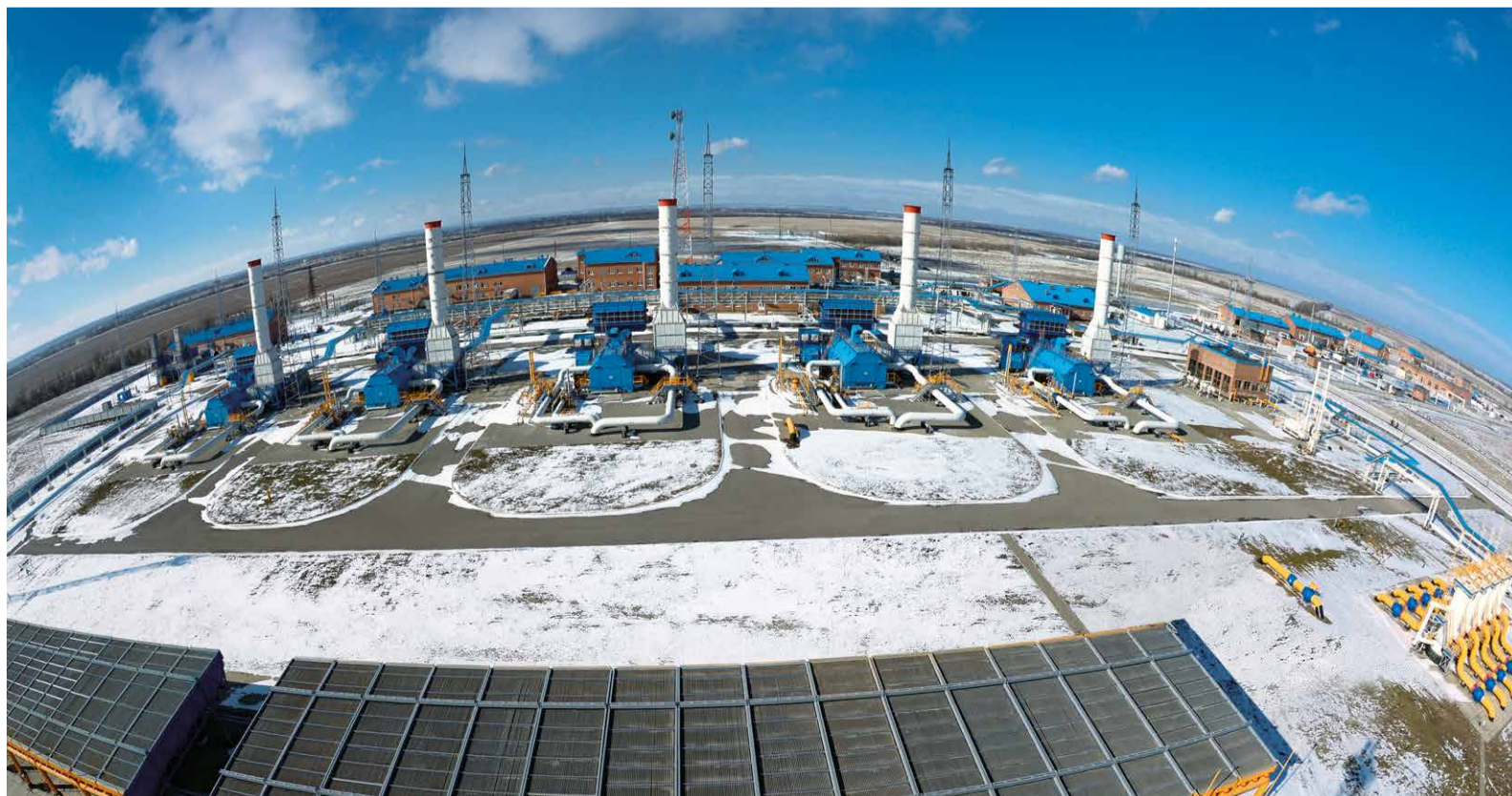
Компрессорная станция «Сальская»
