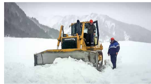
Работы – непростой край
