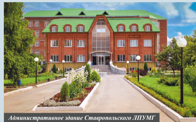
Административное здание Ставропольского ЛПУМГ
