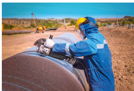
Подготовка к огневым работам
