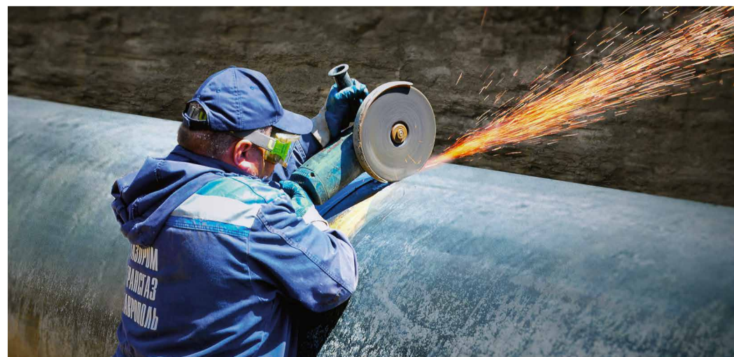
Ремонт сварочного стыка
