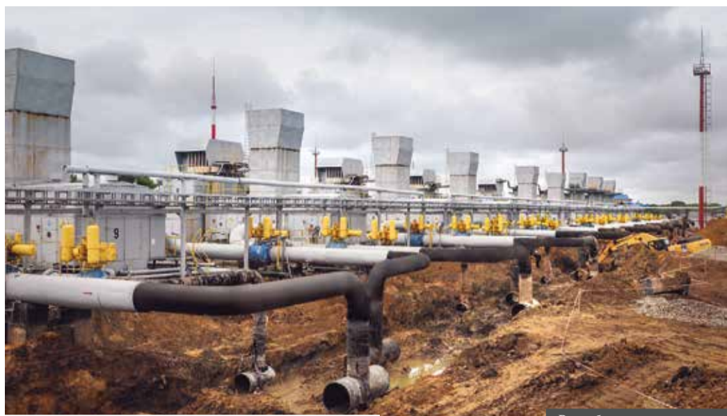
Разработанная траншея технологических трубопроводов
