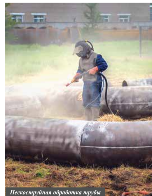
Пескоструйная обработка трубы
