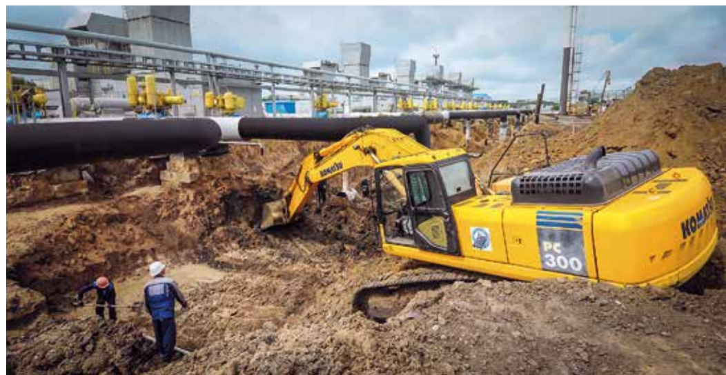
Разработка грунта под фундамент технологических трубопроводов
