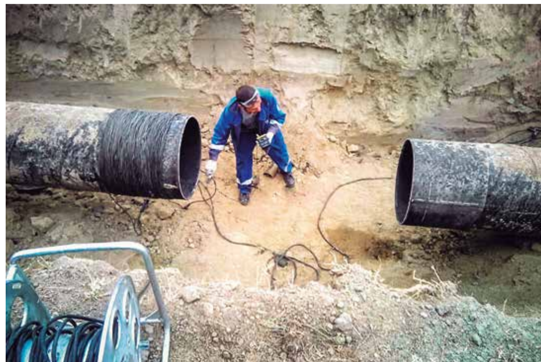
Размагничивание участка газопровода прошло успешно
