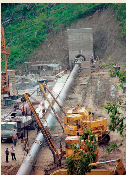
«Голубой поток». Строительство газопровода
