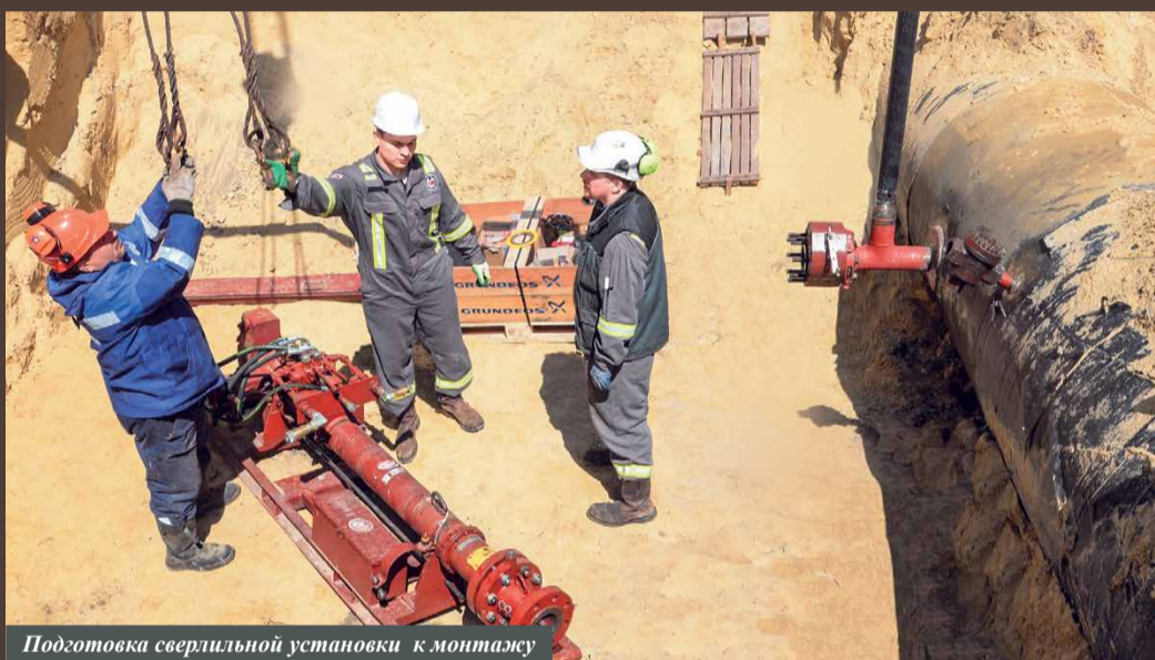
Приварка газопровода-отвода к телу трубы
