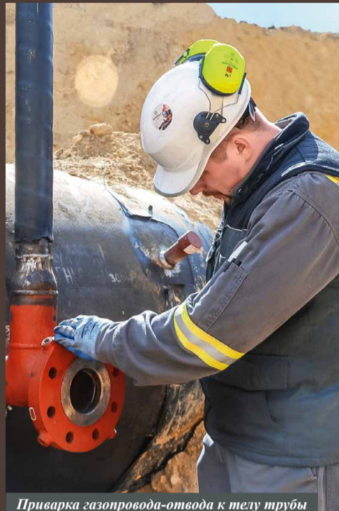
Приварка газопровода-отвода к телу трубы
