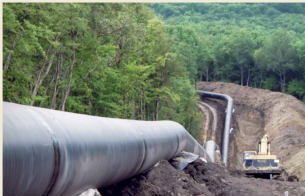
Строительство газопровода «Голубой поток»
