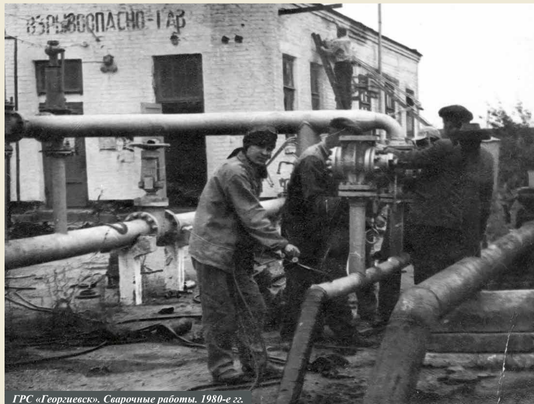
ГРС «Георгиевск». Сварочные работы. 1980-е гг.
