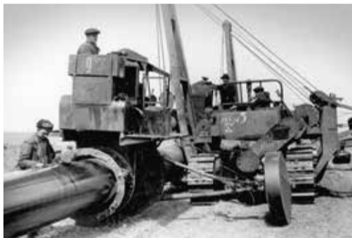
Укладка МГ Ставрополь – Москва, 1955-1956 гг.
