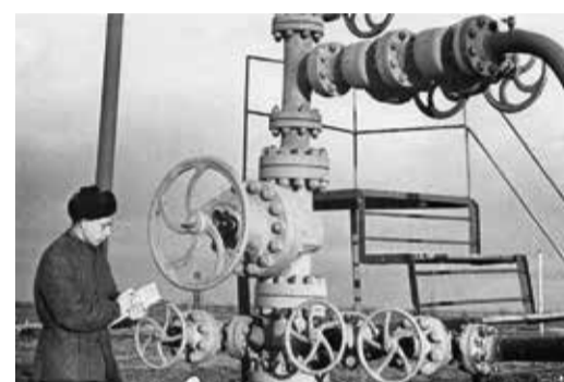
Ввод новой скважины в районе поселка Рыдзювского, 1956 г.
