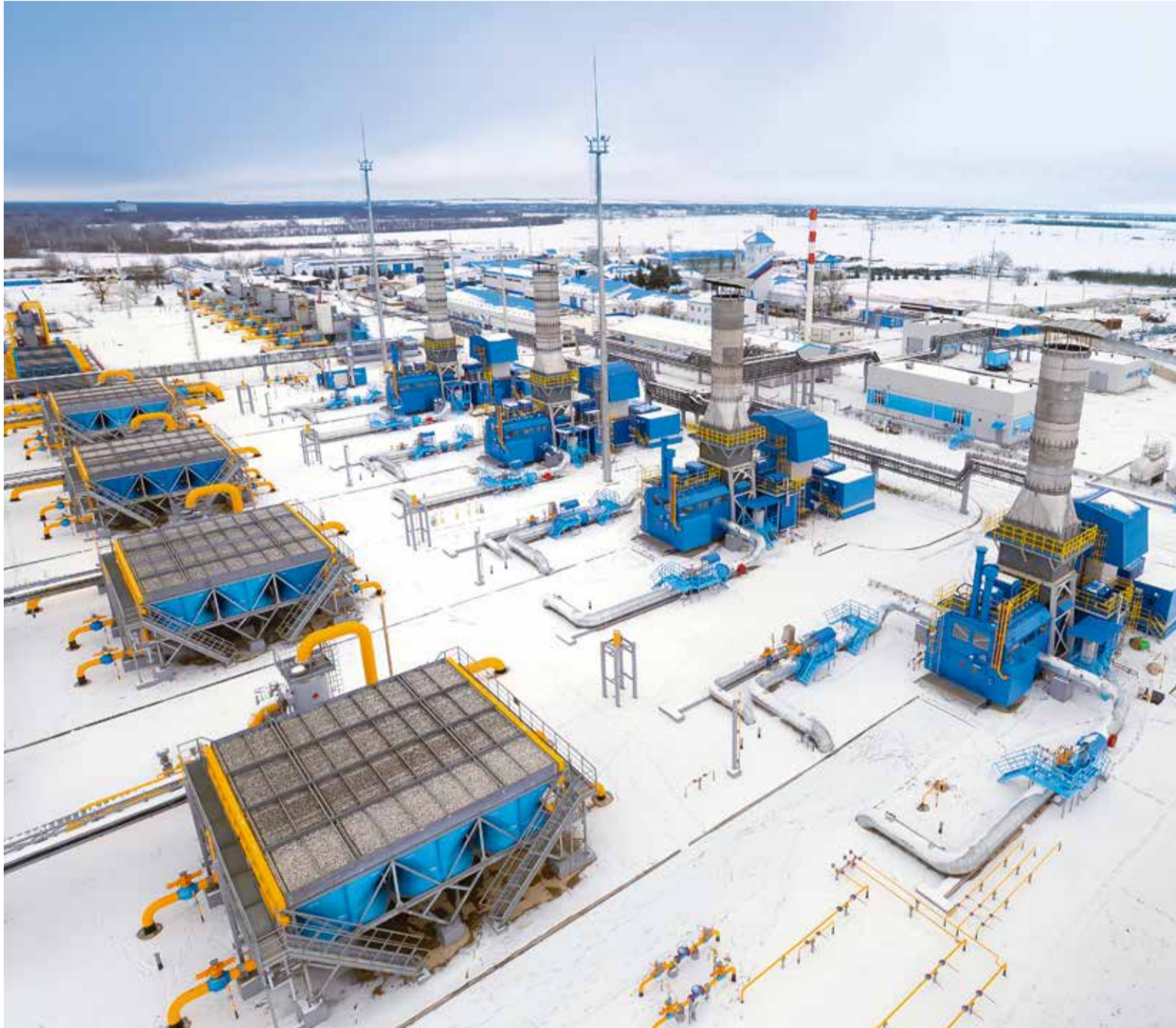
Ввод в эксплуатацию нового цеха на КС-8 Георгиевского ЛПУМГ позволил повысить мощность компрессорной станции, резервирование ГПА и, как следствие, надежность работы всей газотранспортной системы, в том числе при прохождении пиковых нагрузок осенне-зимнего периода.
