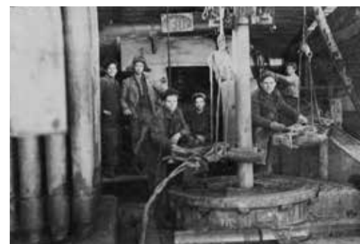
Сенгилеевское месторождение, 1949 г.
