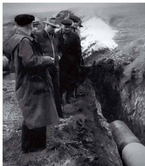
На строительстве газопровода Ставрополь – Москва
